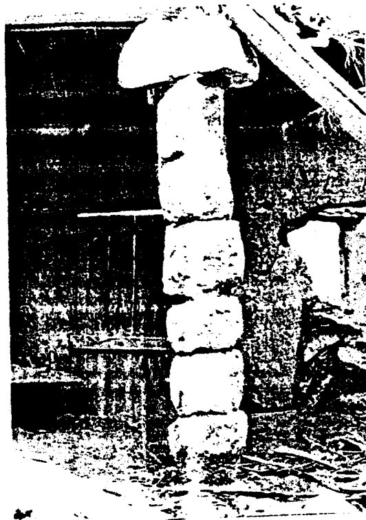
شكل (٤) عمود ميني بجزر أسطوانية الشكل.
